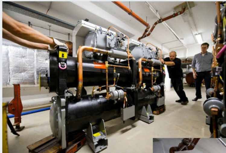
Einbau von zwei Wärmepumpen
