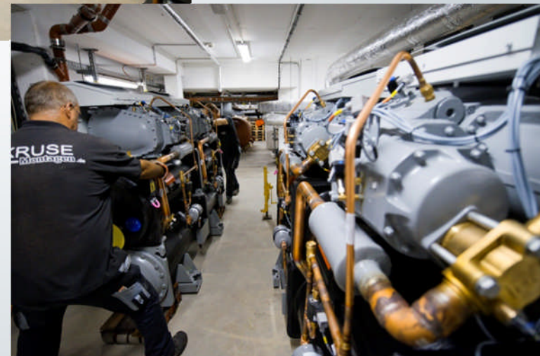
Einbau von zwei Wärmepumpen
