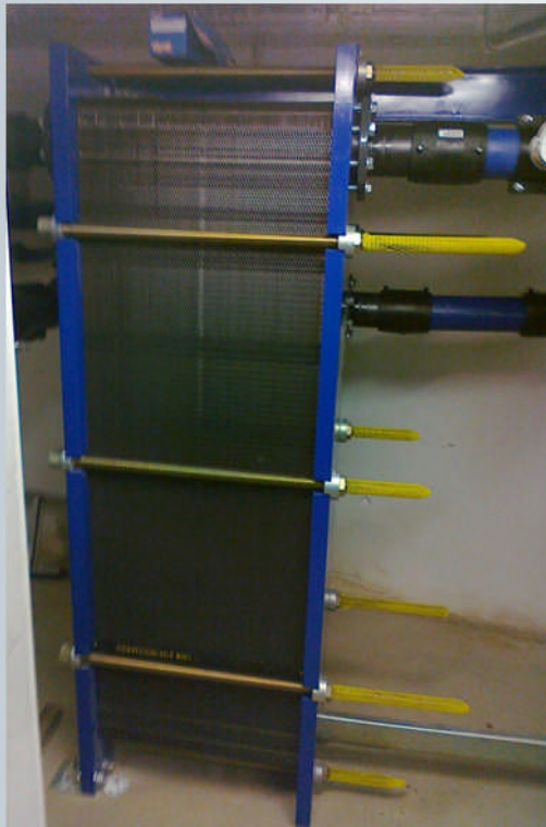
Installation eines Wärmetauschers
